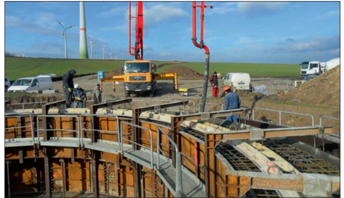
Das Fundament für die neue E 82 entsteht etwa 300 m östlich der Rohrsheimer Großanlage E 112
