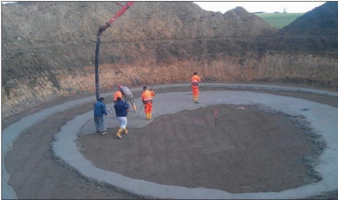
Betonierungsbeginn nach Ausschachtung des knapp 20 m breiten und 4 m tiefen Fundamentloches
