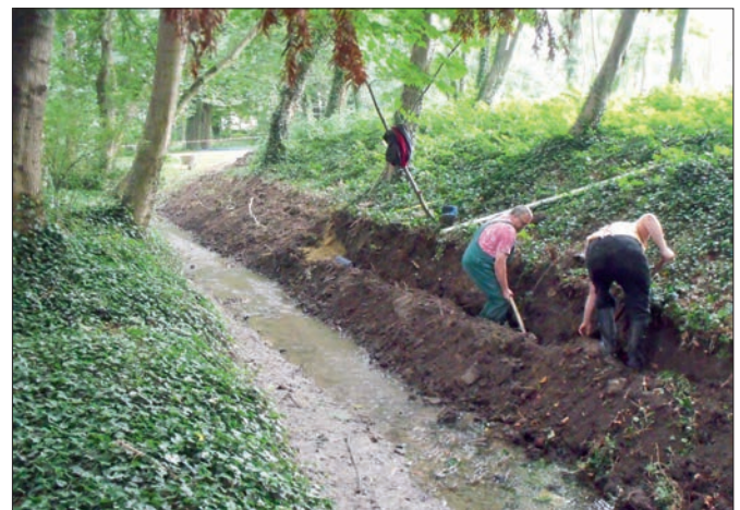
Die HR-Mitarbeiter Frank Gabriel (links) und Heiko Becker (rechts) beim Rohrleitungsbau am Dardesheimer Stadtteich
