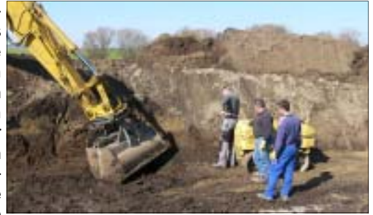
Vor endgültiger Verfüllung der Baugrube wurde nochmals die Funktion der Drainagen geprüft
