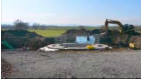
Nach Abschluss der Fundamentarbeiten werden die Baugruben verfüllt und der Boden angeglichen
