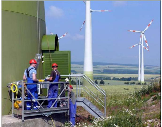
3 Service-Techniker des Enercon-Spezialteams lassen sich im Servicekorb zur Rotorblattreparatur in luftige Höhe fahren
