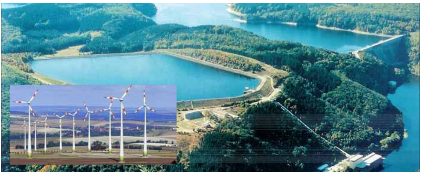
Windstrom nutzen, auch wenn kein Wind weht: Bei Starkwind soll mit Windstrom Wasser hoch gepumpt werden, bei Schwachwind kann das über Turbinen herab fließende Wasser den Windstrom zurück gewinnen
