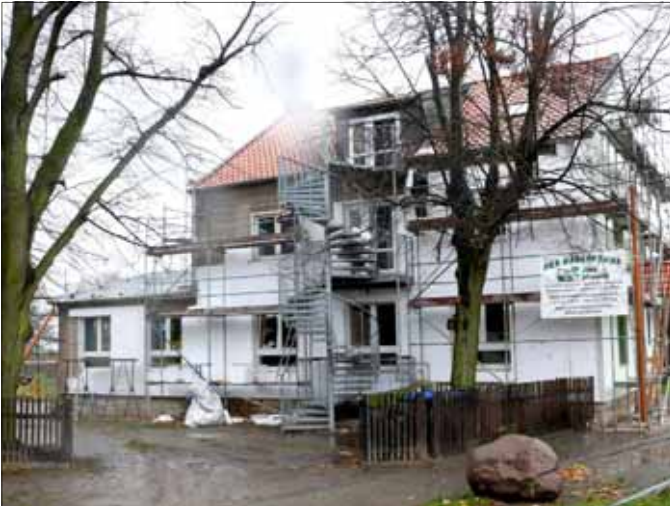
Zur Einsparung von Energiekosten und zur optischen Verschönerung lässt der Dardesheimer Förderverein derzeit die Kita - Fassade renovieren
