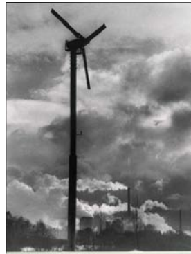
Das schadstofffreie 20 kW Pionier-Windrad der Familie Koch mit 24 m Nabenhöhe und 10 m Rotordurchmesser vor dem qualmenden Kohlekraftwerk Ibbenbüren
