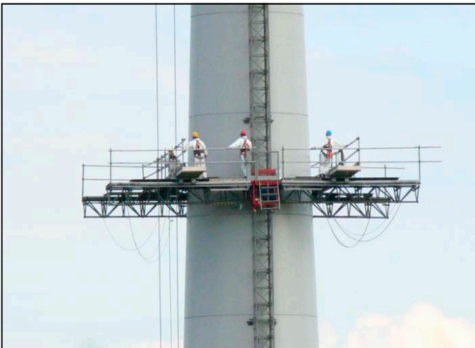
Nach Abschluss der Turmmontage optimieren Malerteams auf fahrbaren Plattformen die farbliche Turmgestaltung
