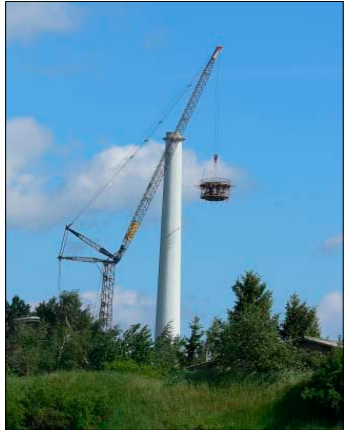
Nach der Abseilung des Gleitschalungskopfes wartet die E-112 auf Rotorgondel und Flügel
