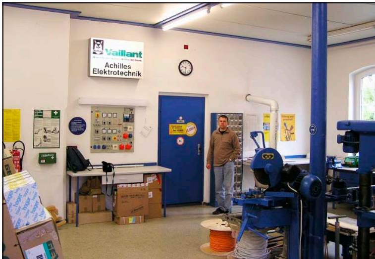
Heute befinden sich im ehemaligen Generatorraum die Werkstatt der Firma Achilles und zwei Photovoltaik-Schalttafeln
