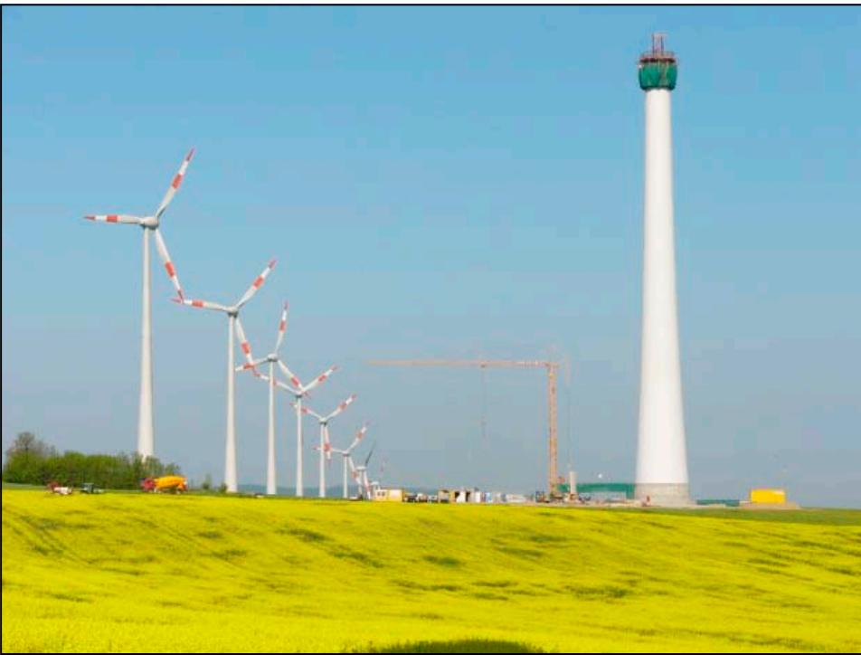
Nach rund 30 Tagen von 0 auf 125: Der Turm der Rohrheimer Großanlage E 112, der knapp 10 m höher ist als die etwa 114 m hohen Dardesheimer Türme
