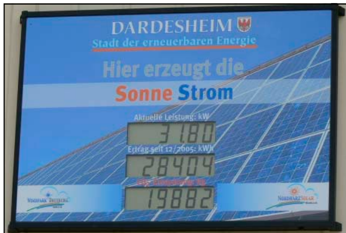
In der obersten Zeile der Solaranzeigen wird die momentane Leistung, in der Mitte die bisherige Gesamtleistung und unten die Schadstoffeinsparung in Kilogramm dargestellt
