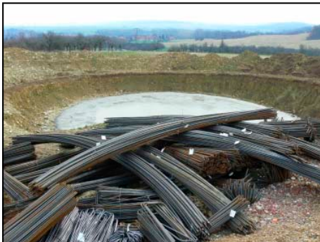
Die auf der Fundamentsohle aufzubauende Eisen-Armierung wiegt 41 Tonnen
