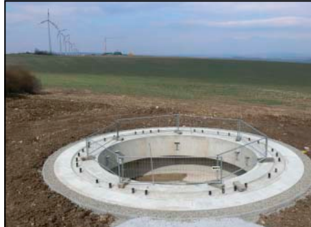
Fertiger Fundamentkopf und Fundamentkeller zum Schutz für Mensch und Tier mit Absperungen geschützt, im Hintergrund die E-112-Baustelle
