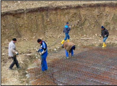
Betonarbeiter bereiten in 4 m Tiefe die Fundamentsohle
