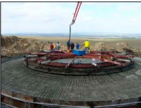
Hier ist das Fundament mit 58 Fuhren und 466 Kubikmeter Beton bereits nahezu verfüllt.
