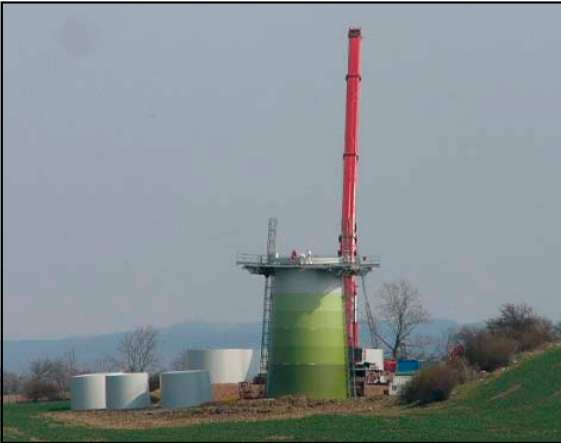
Per Telekran werden die einzelnen Beton-Fertigteile für den E-70-Turm Segment für Segment aufeinander gesetzt (hier am „Pferdestall“ mit Blick nach Osten)
