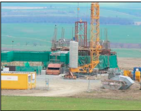
In den nächsten Wochen wird an der Rohrshemer Großbaustelle Hochbetrieb herrschen, hier Blick von der Radarstation in Richtung Norden.
