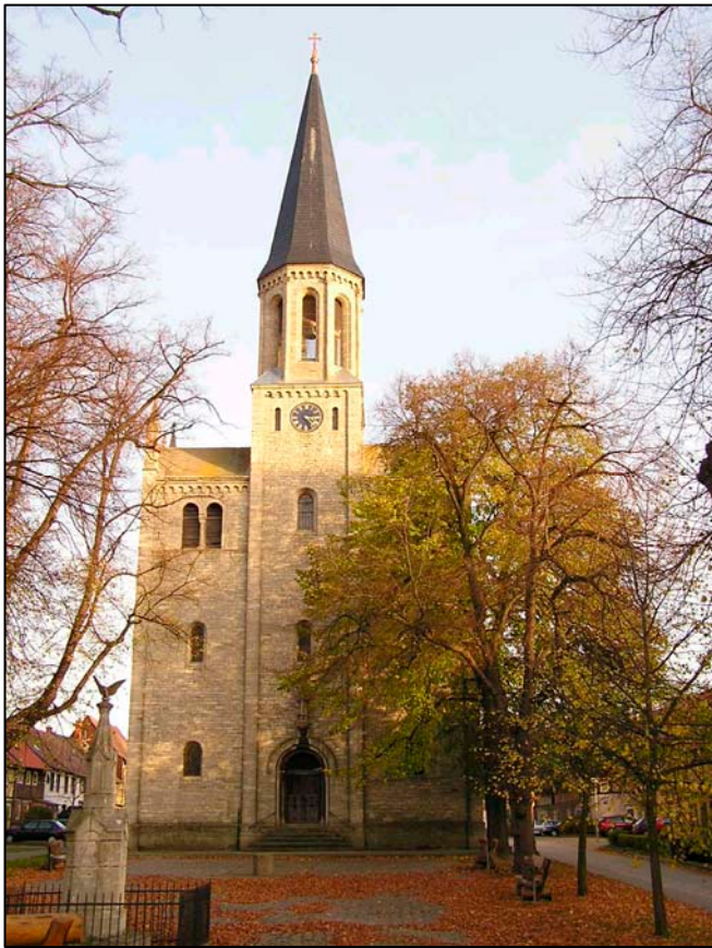
Sankt Stefanie Kirche zu Dardesheim nach der Turmsanierung
