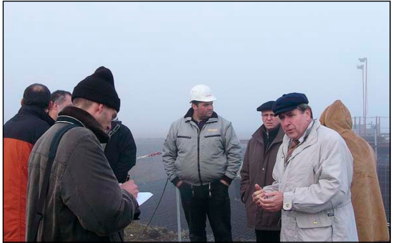
Trotz eisiger Temperaturen nahm sich Landrat Henning Rühle Zeit zu einem ausgedehnten Besuch des Windparks und der neuen E 112 – Baustelle
