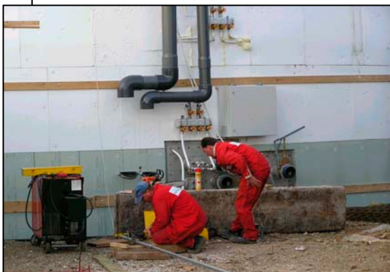
Monteure bei der Installation der Heizung
