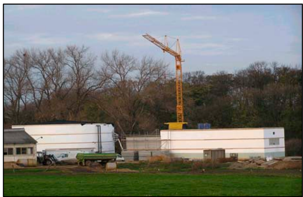
Weiterer Bauabschnitt an der Biogasanlage Zilly abgeschlossen
