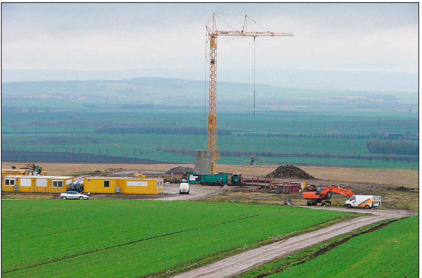
Auf der neuen Großbaustelle nördlich der Radarstation ist durch den Baukran der Fundamentbau weithin erkennbar
