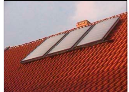
Diese 3 Sonnenkollektoren mit rund 3 Quadratmeter Fläche waren zwischen Mai und Oktober 2003 ausreichend für das gesamte Warmwasser am Brautor 283 A
