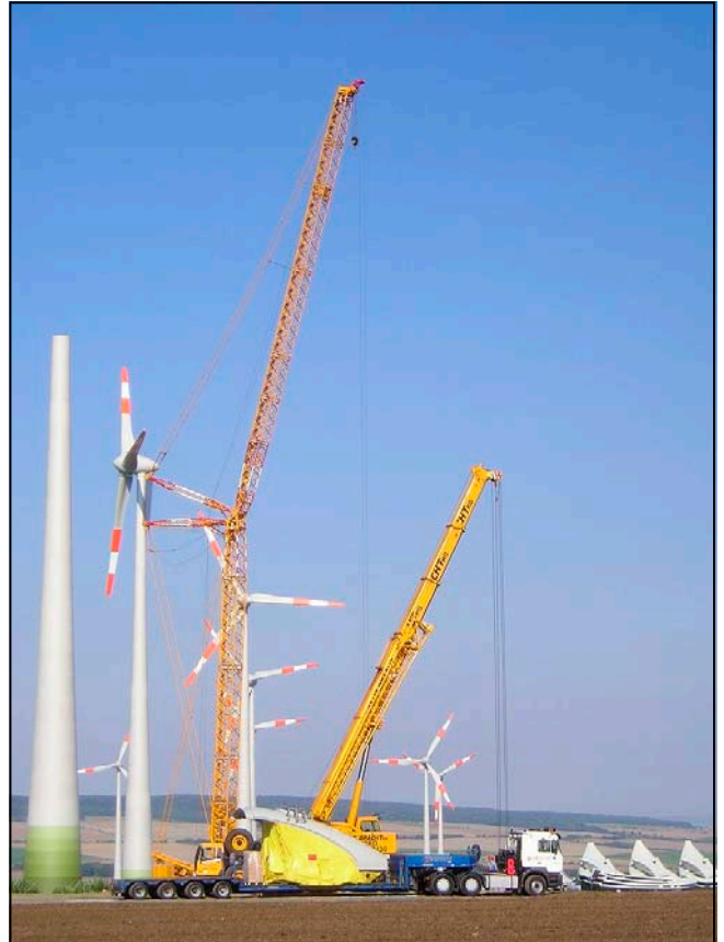
Giganten im Einsatz: Noch höher als die Windräder ist Großkran mit einem Gewicht von 750 mittelschweren Autos
