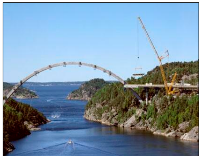
Diese norwegische Fjordbrücke wurde zuletzt von dem Krangiganten montiert, der zur Zeit auf dem Druiberg arbeitet
