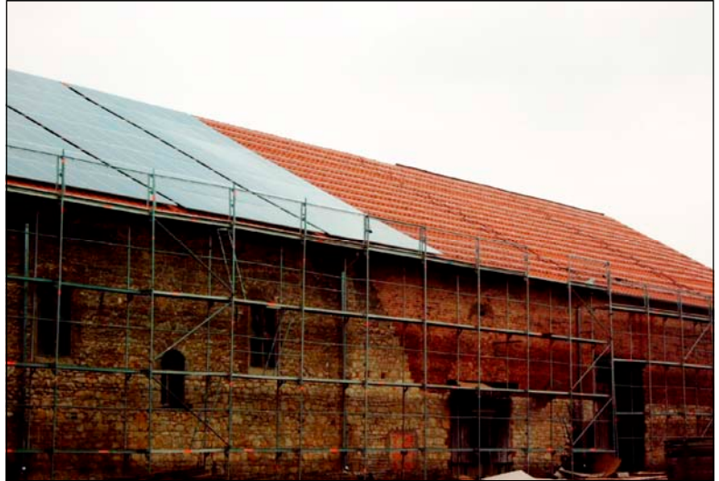
Stück für Stück wurde das Scheunendach mit knapp 500 Modulen überdeckt
