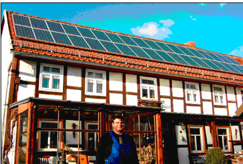
Elektromeister Wilhelm Klopp vor seiner Photovoltaikanlage
