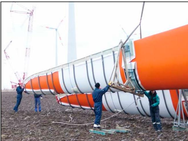
Die drei Flügel werden am Boden vormontiert und der Rotor dann als Ganzes zu der Generator gondel hoch gezogen.
