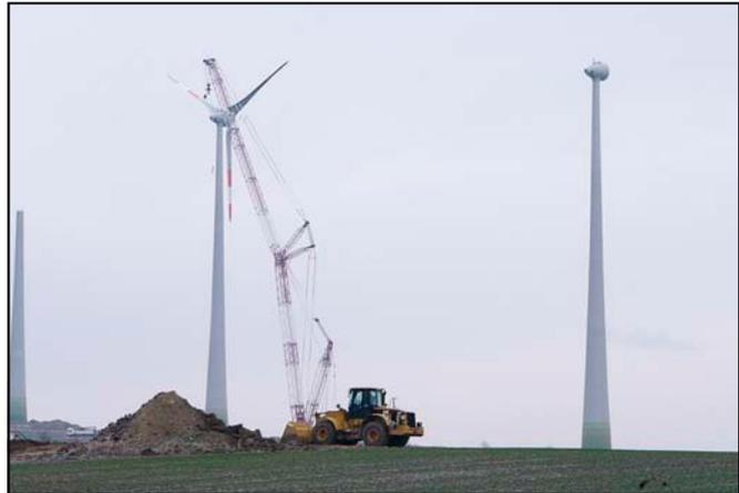
Fertig: Der Rotor mit seinen neu geformten Flügeln ist nun auch an Anlage 17 befestigt. Anlage 16 war als nächste dran.
