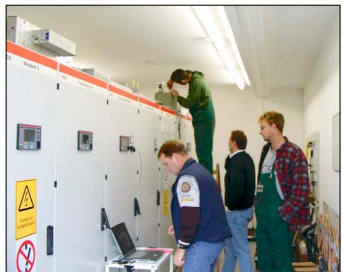
Reparaturarbeiten im Schaltgebäude des Wind-Umspannwerkes in Wasserleben
