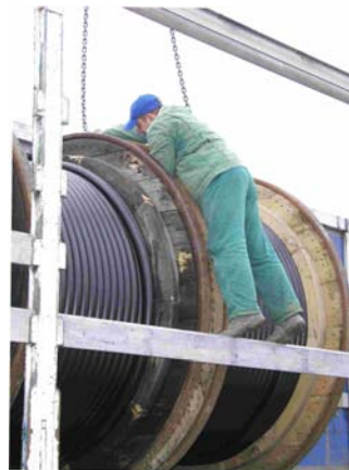
Die Kabelrollen werden mit dem Auto- kran abgeladen
