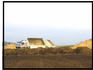
Erdarbeiten im großen Maßstab
