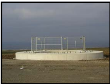
Vorher - nachher Fertiges Fundament
